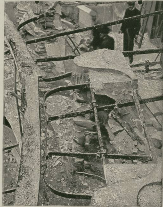
ARMATURES DE BALCONS DES 2 ES LOGES PHOTOGRAPHIE PRISE PENDANT LA DÉMOLITION
