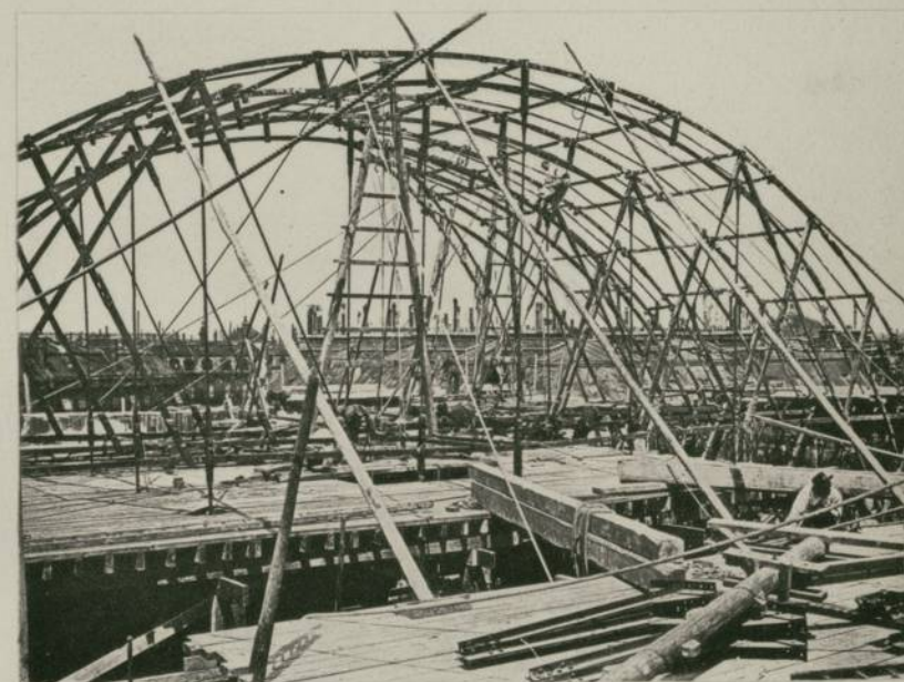
FERMES DE CHARPENTE EN FER FORGÉ - VUE PRISE PENDANT LEUR DÉMOLITION
