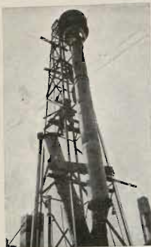
MONTAGE D'UNE CHEMINÉE D'USINE AVEC CAPTE-SUÏE.
