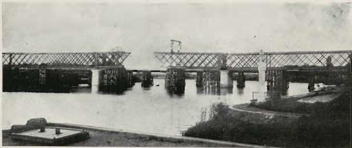
PONT DE BRANNE. — RELEVAGE TERMINÉ. — RESTE LE RIPAGE. — 15 AVRIL 1946.
