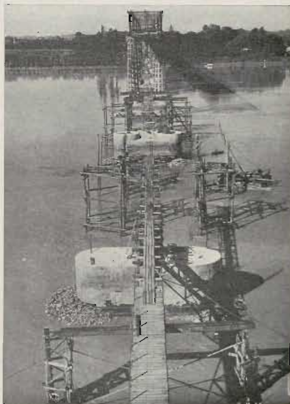
LE PONT DE CURZAC DONT LA RECONSTRUCTION DES PILES ET CULÉES ET LES TRAVAUX DE BÉTON ARMÉ AVAIENT ÉTÉ CONFÉJÉS A L'E. G. I. S. O.
