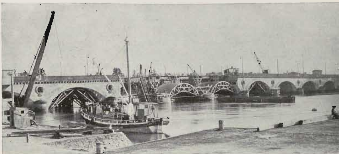
PONT DE LIBOURNE. — VUE D'ENSEMBLE DU CHANTIER, CÔTÉ AVAL. MONTRANT LES DEUX CINTRES DES VOÛTES 4 ET 5.
