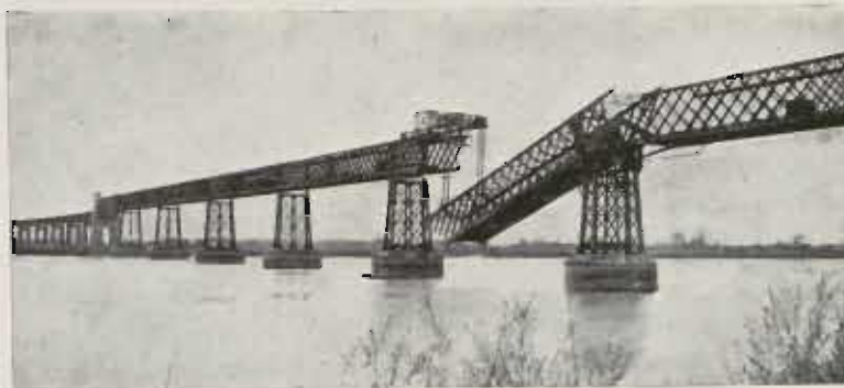
Relevage et reconstruction du pont de Cubzac (S. N. C. F.) sur la Dordogne
